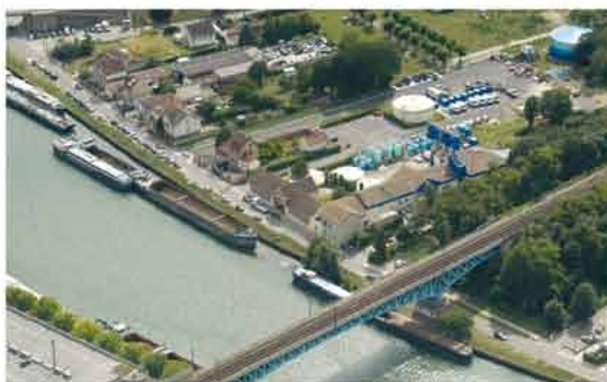
Instalación de SEFO en Francia.
